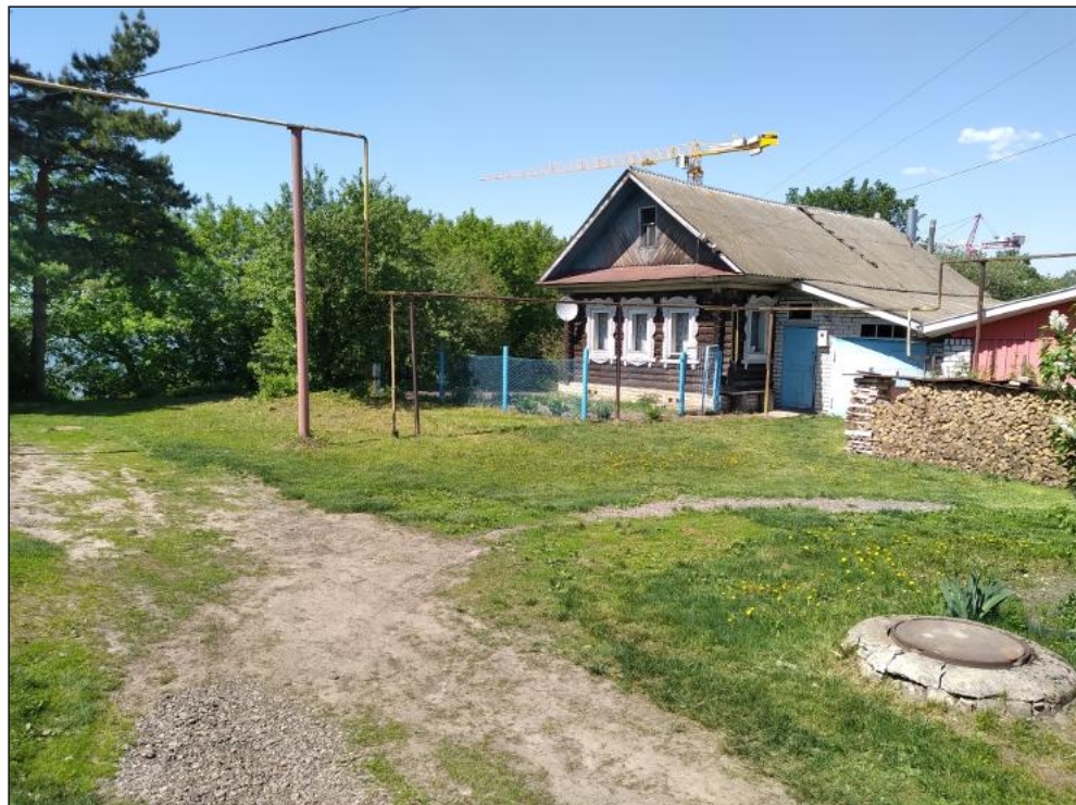
Илл. 25. Видовая фотофиксация трассы проектируемого объекта «Газопровод-ввод к жилому дому по адресу: Нижегородская область, Городецкий район, г. Городец, ул. Щорса, д. 17/1 (Код объекта 152-22-102-042190)». Точка фотофиксации 3. Вид с юго-востока на начальный участок трассы проектируемого газопровода (точка врезки в существующий надземный стальной газопровод)
