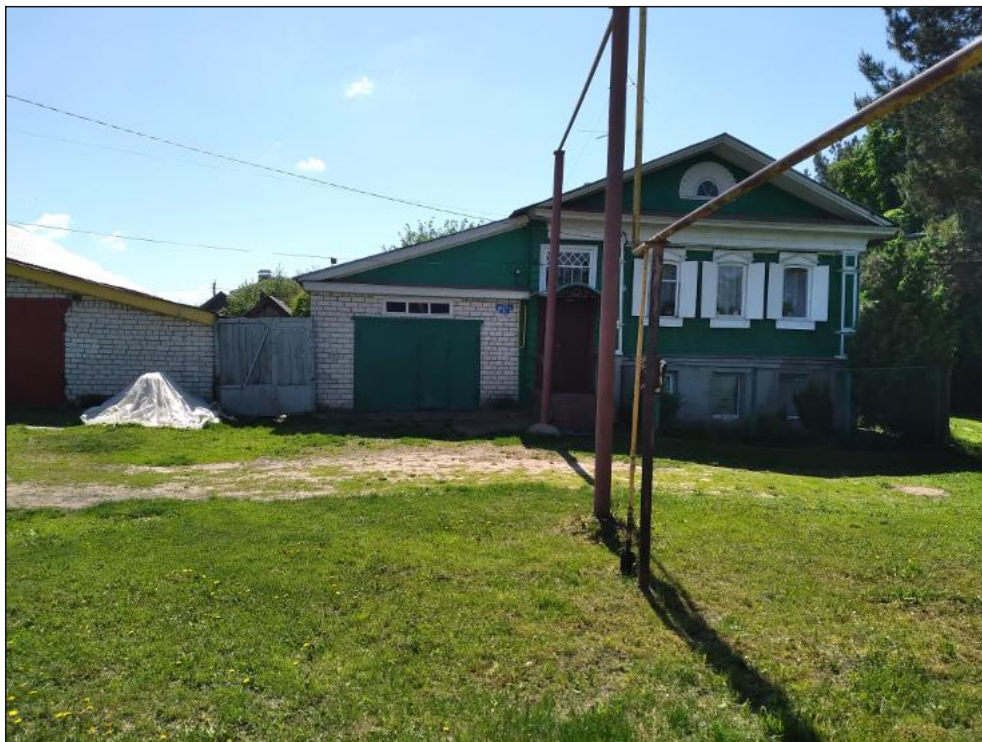
Илл. 22. Видовая фотофиксация трассы проектируемого объекта «Газопровод-ввод к жилому дому по адресу: Нижегородская область, Городецкий район, г. Городец, ул. Щорса, д. 17/1 (Код объекта 152-22-102-042190)». Точка фотофиксации 2. Вид с ССВ на начальный участок трассы проектируемого газопровода (точка врезки в существующий надземный стальной газопровод)
