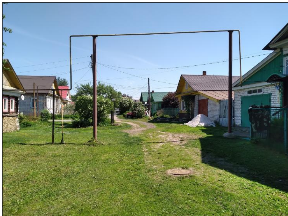
Илл. 21. Видовая фотофиксация трассы проектируемого объекта «Газопровод-ввод к жилому дому по адресу: Нижегородская область, Городецкий район, г. Городец, ул. Щорса, д. 17/1 (Код объекта 152-22-102-042190)». Точка фотофиксации 1. Вид с ЗСЗ на начальный участок трассы проектируемого газопровода (точка врезки в существующий надземный стальной газопровод)
